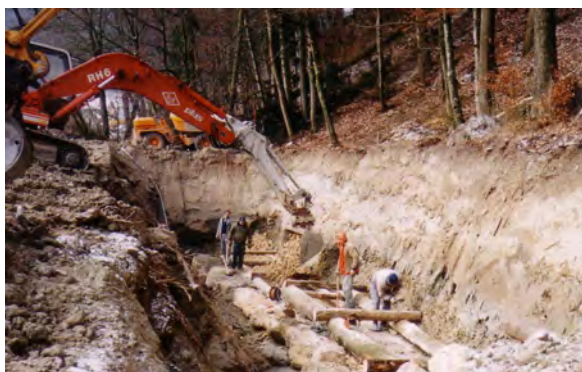
Illustration 1 Coup d'œil sur un chantier
