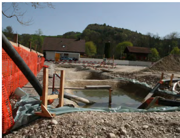
Illustration 2 Evacuation des eaux de chantier en surface
